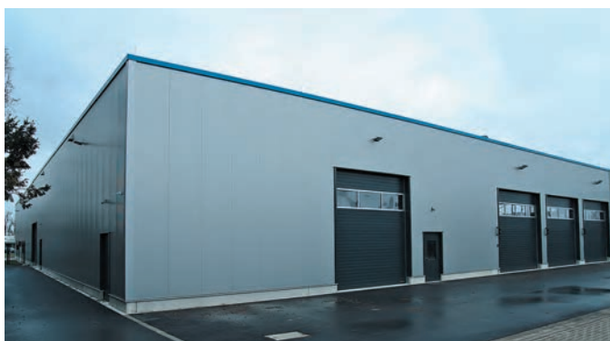
Die neue Logistikhalle in Bad Nenndorf beherbergt auch Material und hauptamtliches Personal des EU-Moduls.
